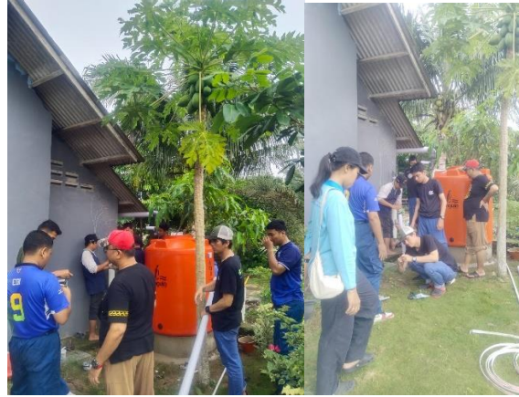
Gambar 1. Pemasangan Instalasi Pemanen Air Hujan
