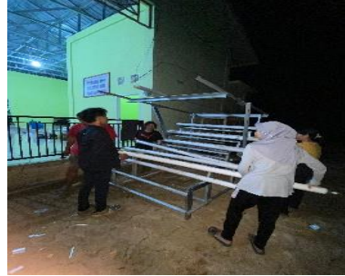
Gambar 3. Proses Pembuatan Instalasi Hidroponik
